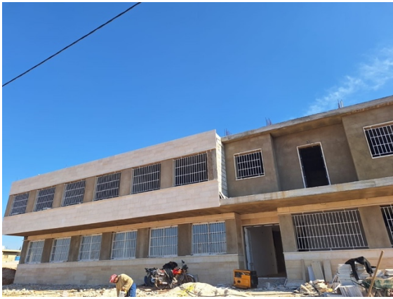
Le nouveau bâtiment de l'école Esprits Libres en cours de finition
